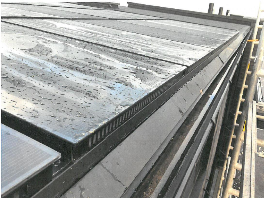
Figur 1.5.18. Afslutning af Ennogie solcelle elementer i taget.
