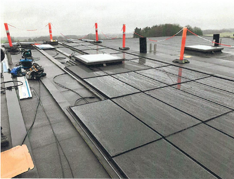
Figur 1.5.17. Ennogie solcelle elementerne bliver monteret med et lille overlap og med "Dummy" moduler af "alucubon" omkring Velux vinduet.
