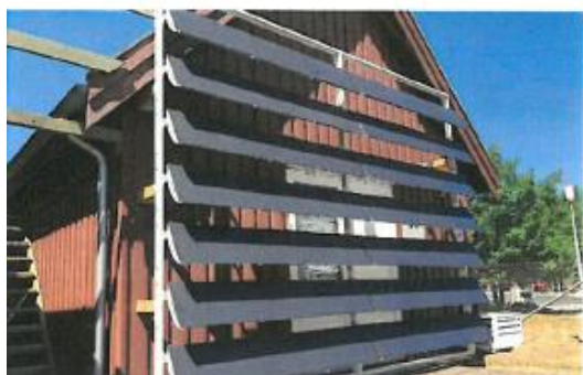
Eksempel med vinklede solceller til facader og gavle fra SolarLab
