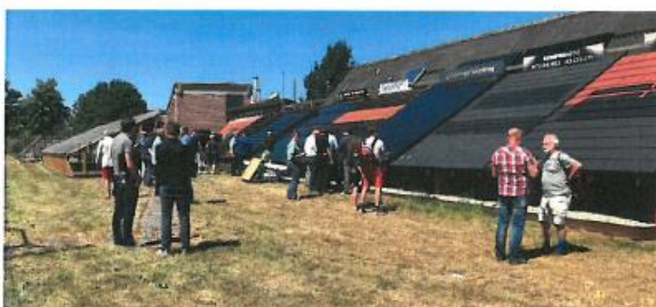
BIPV Demosite på Teknologisk Institut i Tåstrup. Her tagsystemer med bygnings indpassede solceller.
