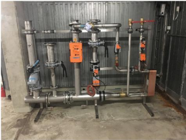
Figur 18 Den færdige demonstrationsopstilling af koncept for køleflade som varmekilde.
