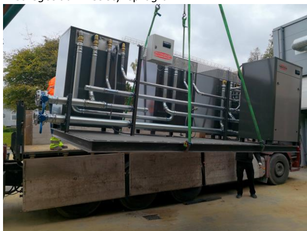
Aflæsning af varmepumpesystem hos Unika
