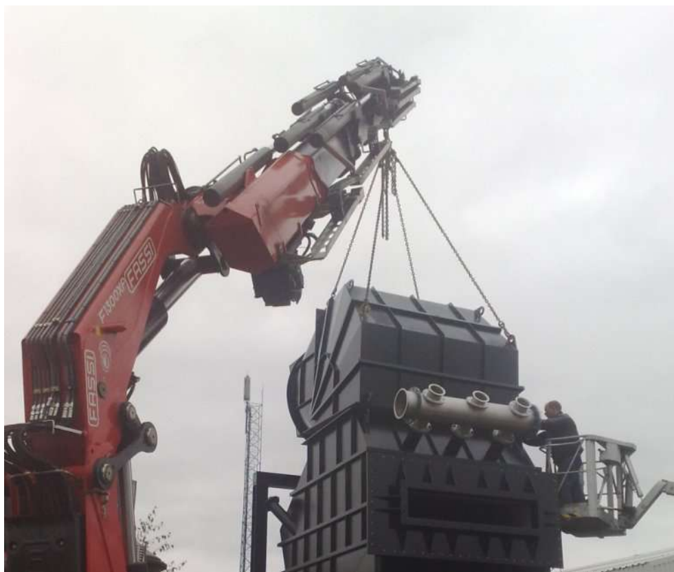
Figur 3.3 Montage af ovn elementer
