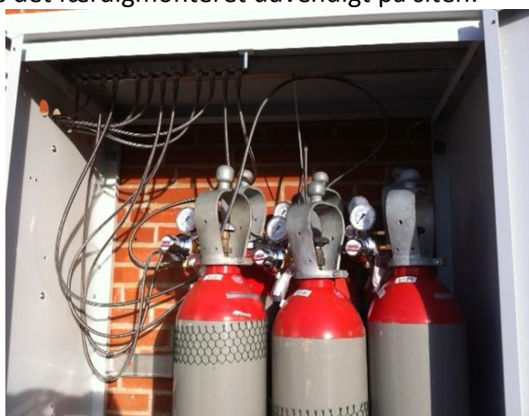
Billede 23: Flaskelager monteret med slanger og regulatorer
