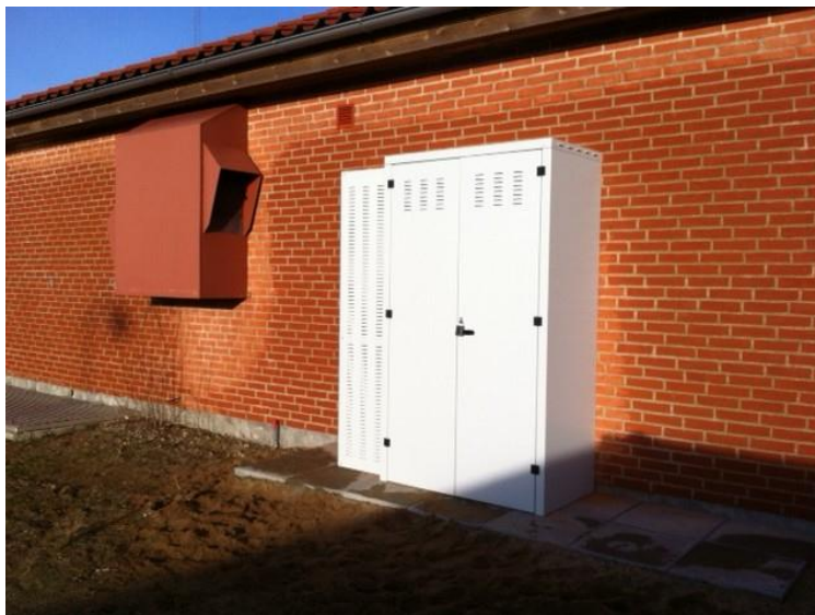
Billede 24 Færdig udvendig installation i Gedved
