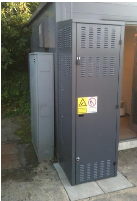
Billede 14: Flaskeskab installeret (5kW site)
