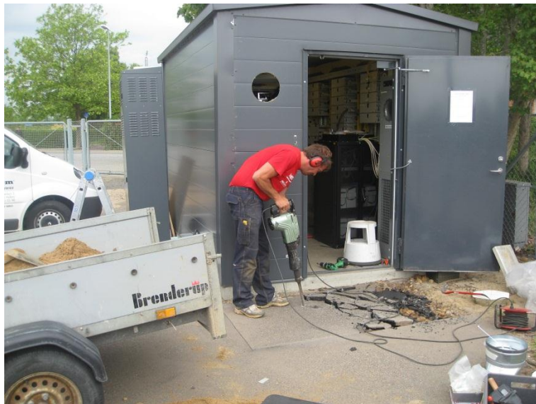
Billede 11: Klargøring til montage af flaskelager
