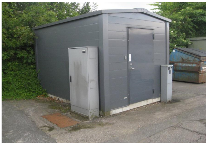
Billede 10: En 5kW-site på P-plads før klargøring og installation
