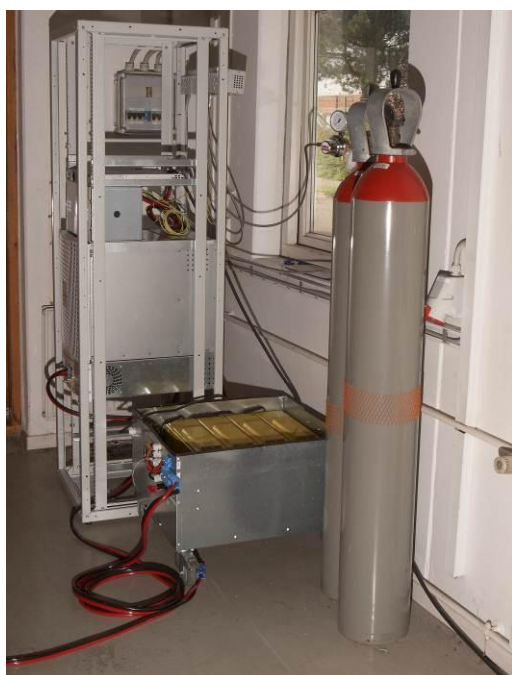
Billede 12: Dantherm Power's brændselscelleanlæg med brintlager.
