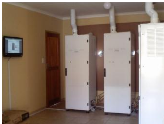
Billede 14: Installation af 4 brændselscelleanlæg, sydafrika
