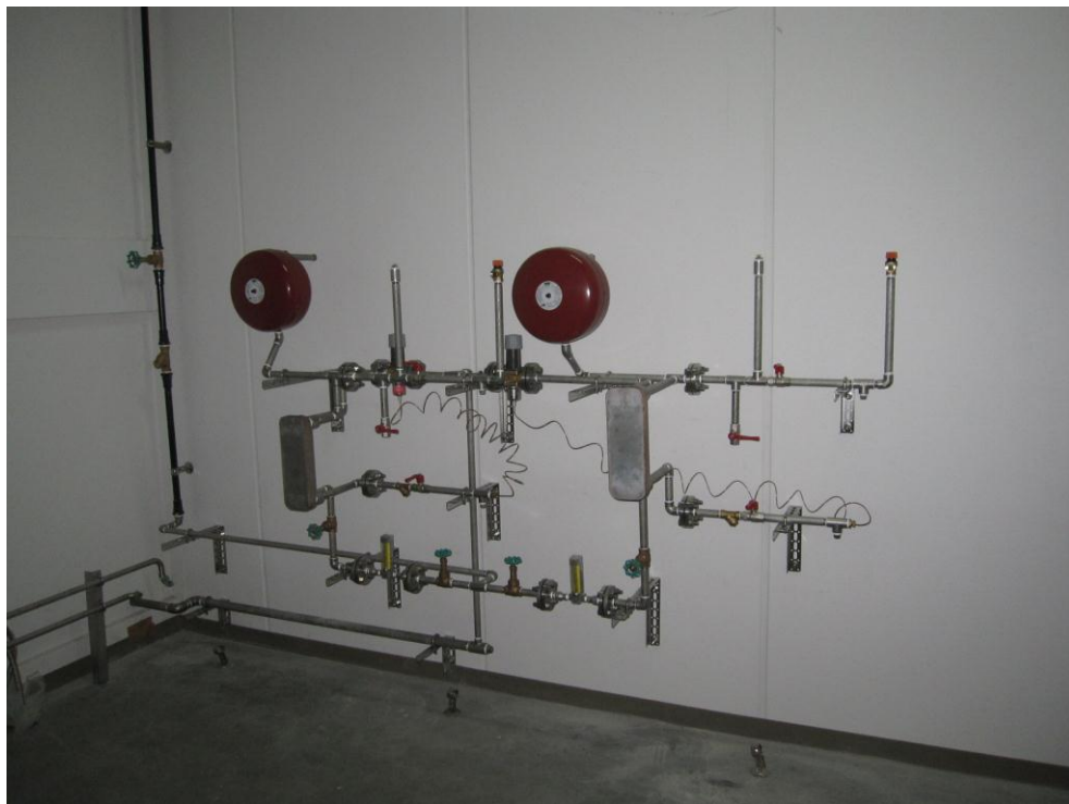
Billede 17: Installation der venter på de genopbyggede brændselscellesystemer på lokation nr. 2
