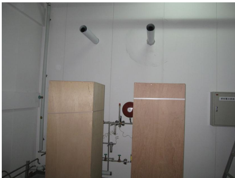
Billede 18: installation af brændselsceller på lokation nr. 2
