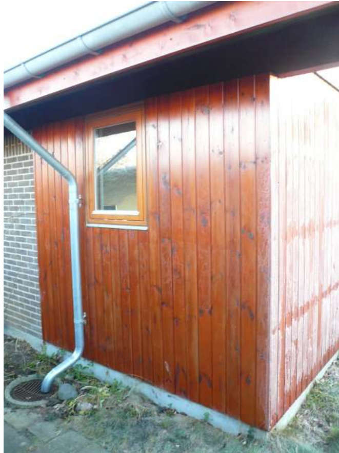
Figur 1.5. Ny let væg mod nordvest. Billedet er taget en morgen med rim og viser derfor væggenes bærende skel.
