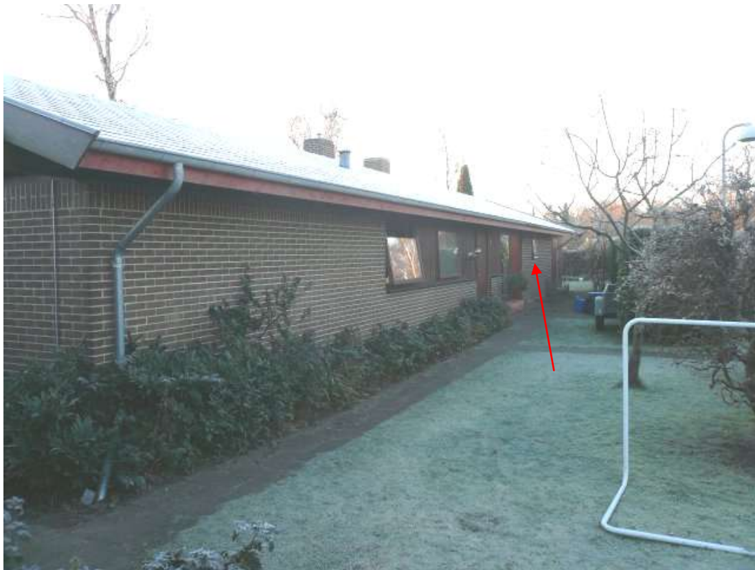
Figur 1.6. Nordvestfacaden. Pilen viser det nye vindue.
