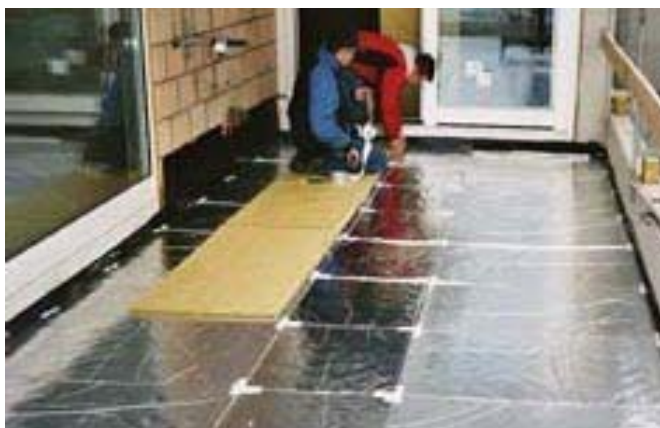
Figur 17. Vakuum isolering til gulv. Her uden gulvvarmeslanger.
