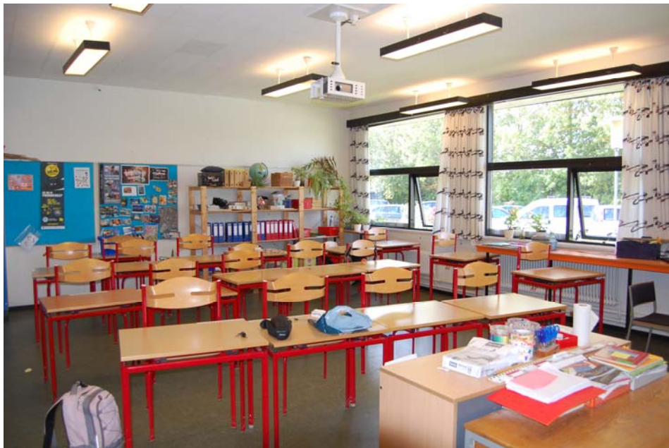
Figur 11. Belysningsanlæg i 3-modulers klasselokale. Det ses at solafskærmning på vinduerne består af manuelt betjente indvendig gardiner.
