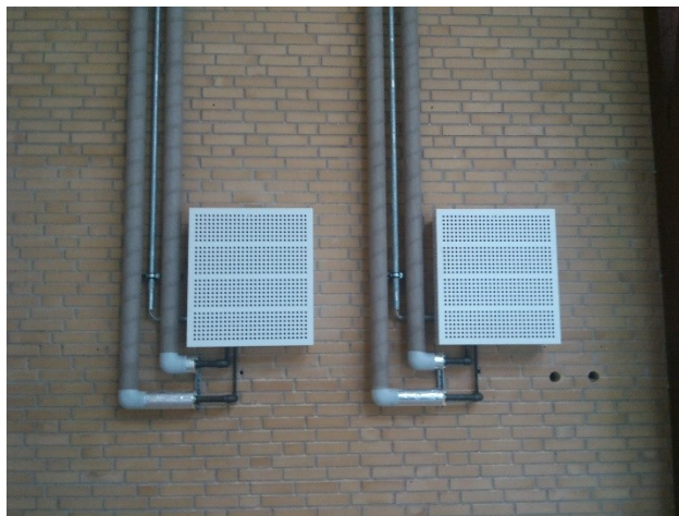
Figur 16: Eksternt luftindtag og Entra'er til forvarmning eller forkøling af indtagsluften
