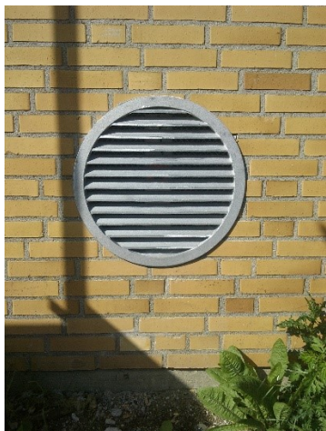
Figur 16: Eksternt luftindtag og Entra'er til forvarmning eller forkøling af indtagsluften
