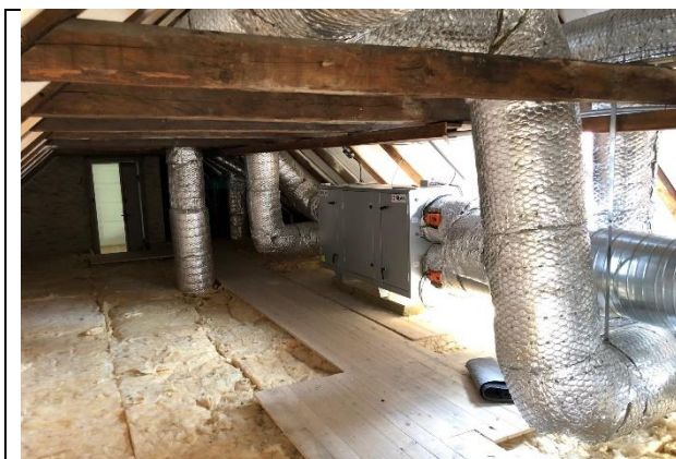
Central løsning, Aggregat på loft
