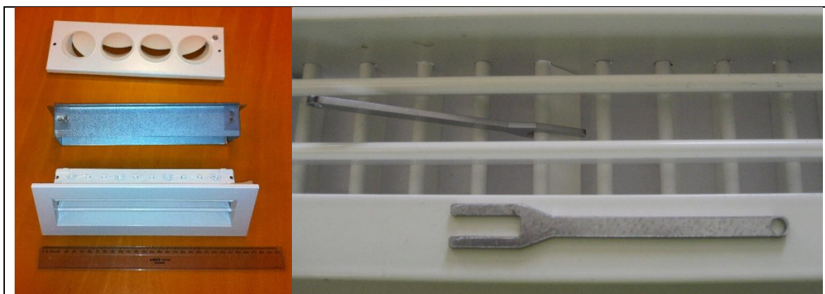
Armaturer og gaffel til justering af retning på "gæller" i indblæsningsarmatur.
