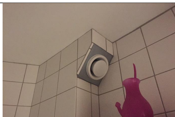
Central løsning, udsugning i bad
