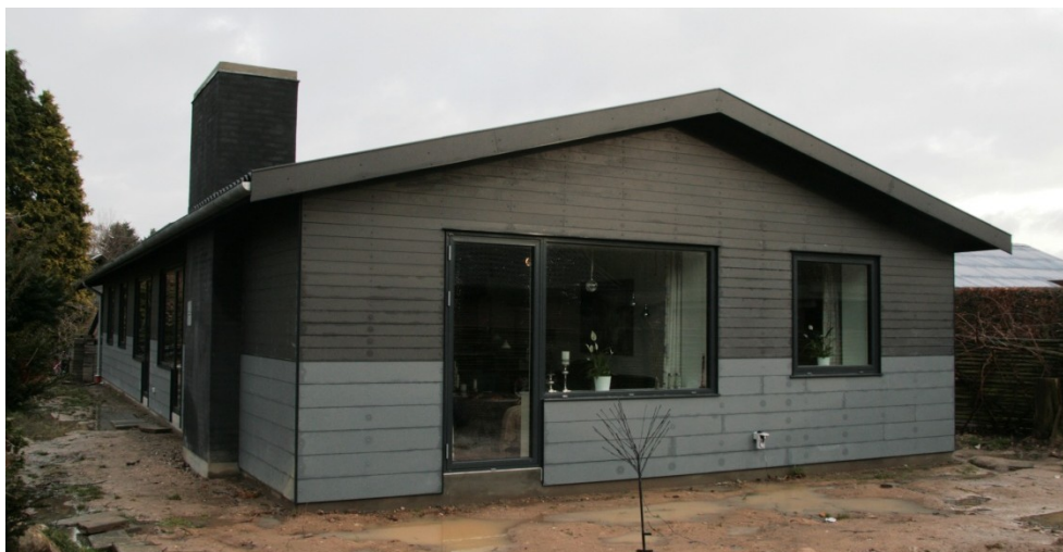
Fig. 3 Huset på Udbakken efter energirenoveringen
