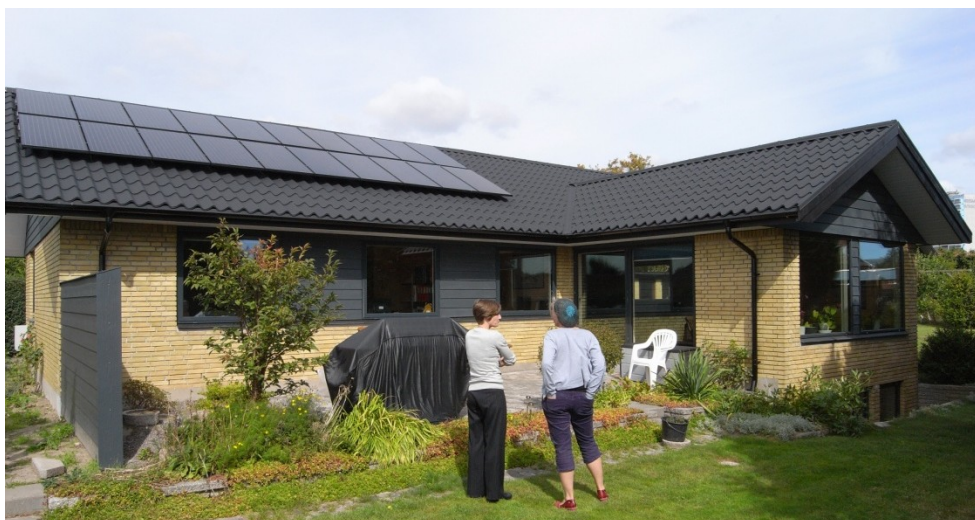
Fig. 7 Huset på Sommerbuen efter energirenoeringen
