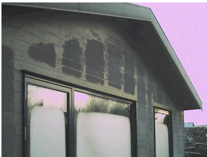
Fig. 4 Foto fra termograferingsrapporten, der viser udvendig rim på de nye tre-lags vinduer.
