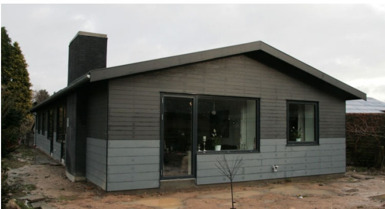
Huset på Udbakken efter energirenoeringen
