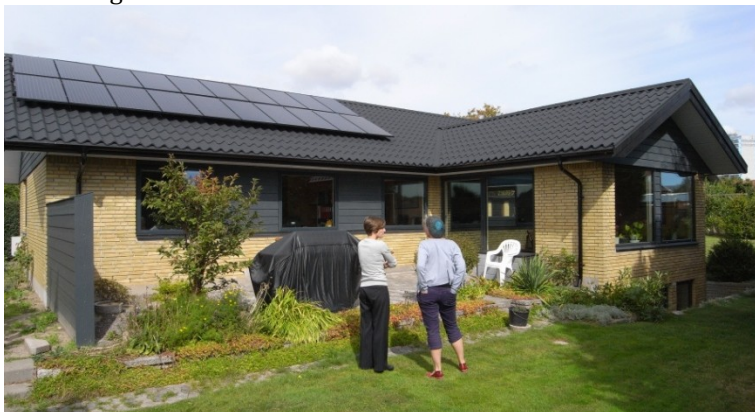
Huset på Sommerbuen efter energirenoveringen
