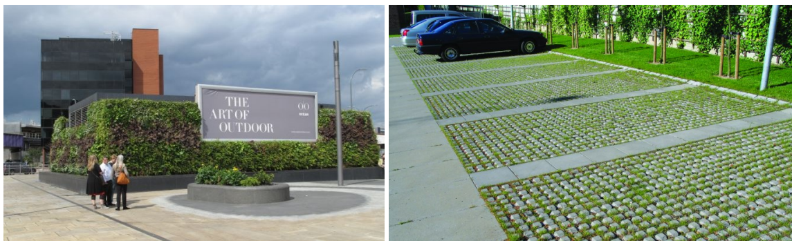
Figur 14-4. Tv. ses en grøn facade. Th. ses et eksempel på en permeabel belægning på p-plads.
