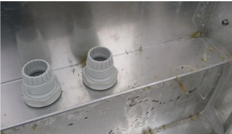
Eksempel på tæt gennemføring internt i elementet
