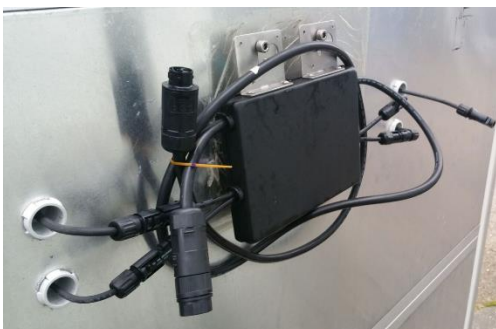
Placering af mikroinvertere på bagside af element.
