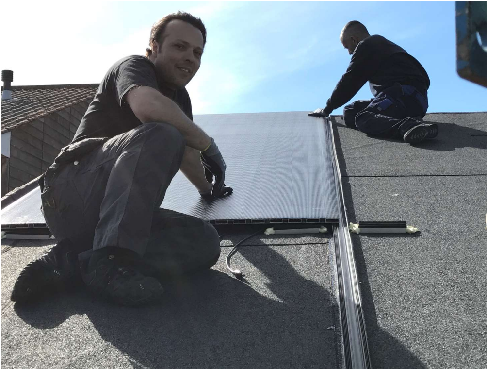
Figur 4. 7 De anvendte Racell solcelle elementer er i princippet selv bærende. Så løsningen med et fuldt tagpap undertag er lidt "livrem og seler". Samling i forhold til montage profiler laves med selvskærende skruer i de yderste 5 cm af solcelle panelerne, hvor der ikke er solceller.
