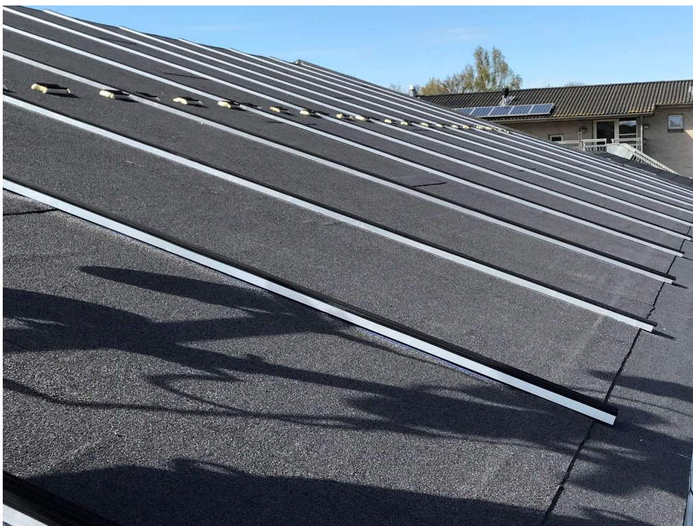
Figur 4. 6 Det forberedte tagpaptag før solcelleelement montagen
