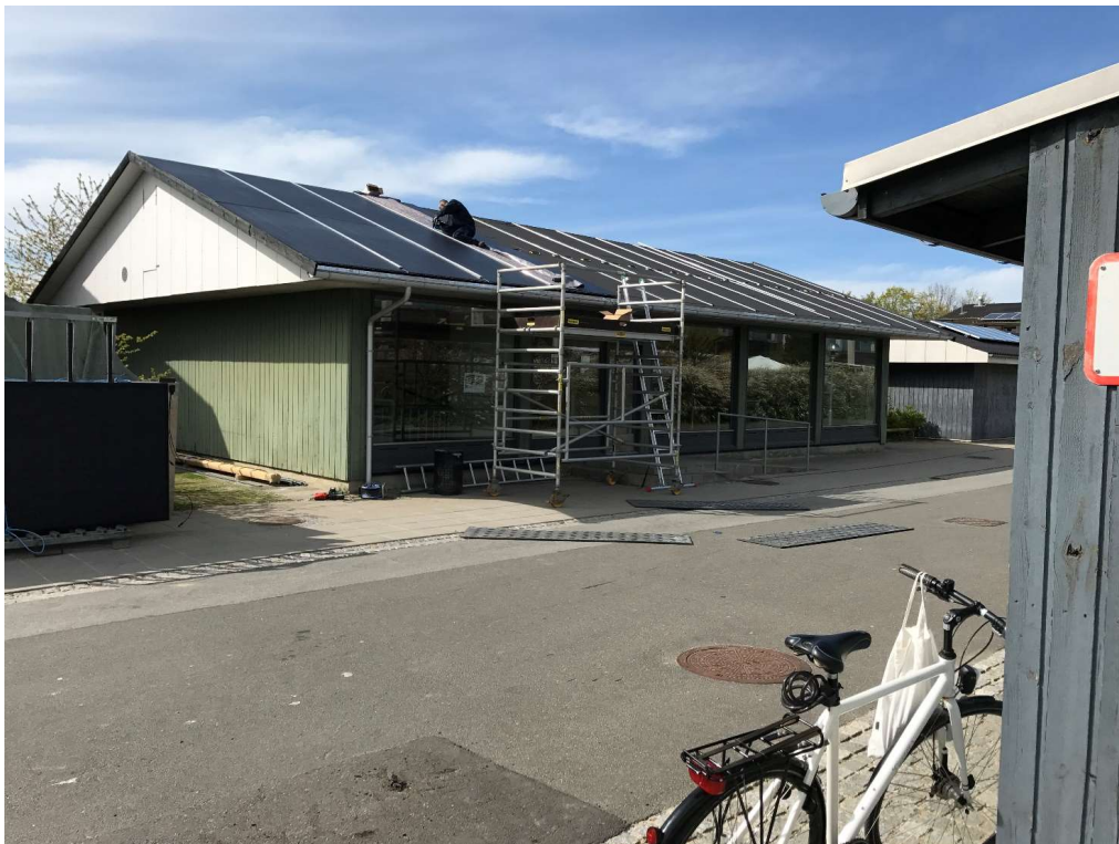
Figur 4. 5 Montgearbejde på vaskehus
