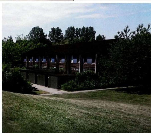
Flere større boligblokke får de nye ITM energianlæg næste år. Måløv Park er netop gået i gang.
