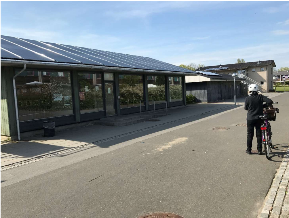
Figur 4. Det færdige solcelletag på vaskehuset i Måløv Park
