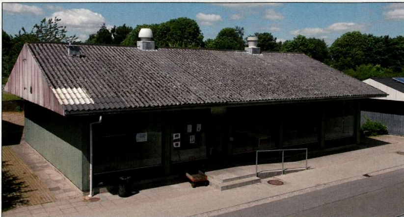
Inden opsætningen af tagbeklædningen.
