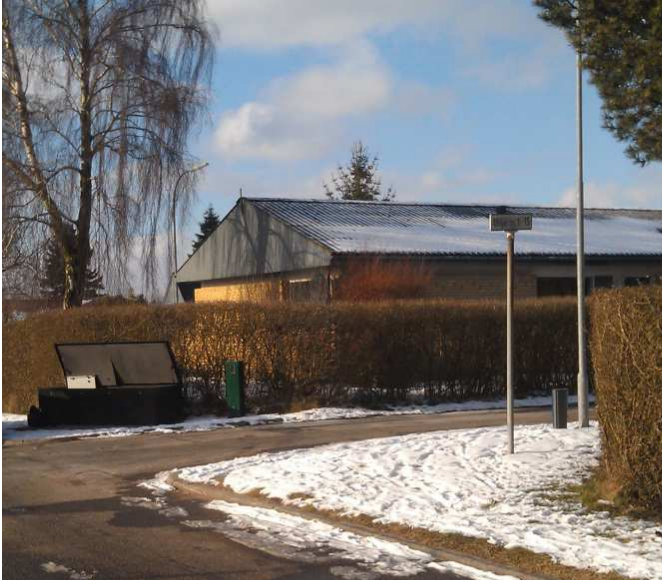
Figur 3: Demonstrationen i Tilst inkluderer 8 parcelhuse fra 70'erne. Fjernvarmetemperaturen til disse huse reguleres fra blandeshunt etableret i terræn (fremgår af billedet).
