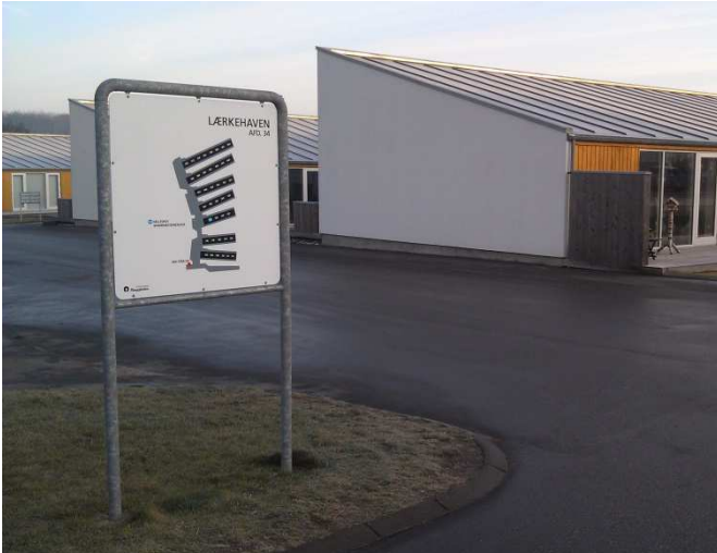
Figur 4: Demonstrationen i Lystrup inkluderer 40 lavenergihuse fra 2010. Det nye lavtemperaturfjernvarmenet er tilsluttet en fælles varmecentral med blandeshunt og booster-pumpe.
