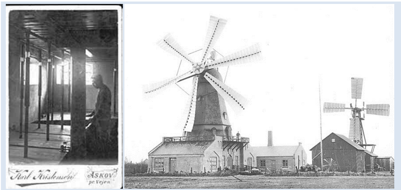
”ELEKTROLYSEKÆLDEREN UNDER POUL LA COURS MØLLEBYGNING I ASKOV, CA. ÅR 1900. I KÆLDEREN STOD 10 ELEKTROLYSEKAR. STRØMMEN TIL ELEKTROLYSEN KOM FRA JÆVNSTRØMSDYNAMOER TRUKKET AF MØLLEN. I
