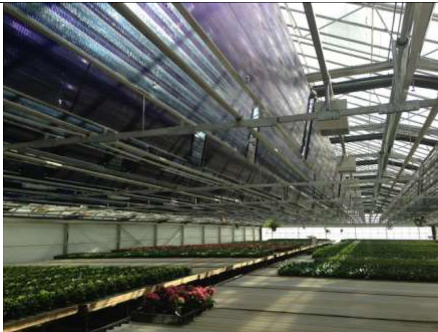
Solfangerfelt nr. 2 – Roterende soldæk på i alt 614 m 2
