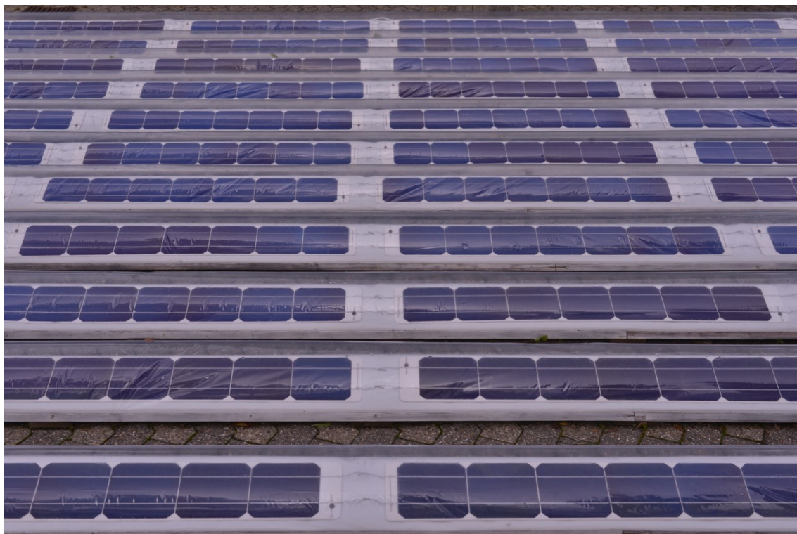
Figur 9. Pilotanlægget i drift i Skive hos Eniig. Anlægget bestod af i alt 12 SunTube moduler monteret på tilhørende underdele (ballast). Alle modulerne var forbundet i serie – både elektrisk og med hensyn til luftcirkulation.
