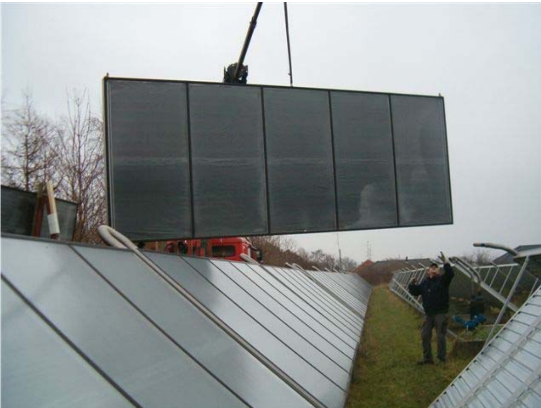
Figur 3. Solfanger fra Marstal nedtages.
