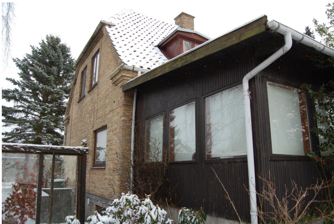
Figur 8. Gavl mod nord med tilbygningen på den vest vendte facade.
