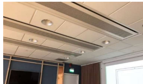
Solus beams in Munksjötårn
