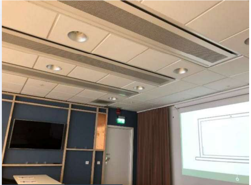
Solus beams in Munksjötårn
