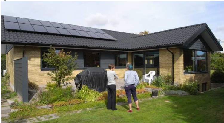
Huset på Sommerbuen efter energirenoveringen
