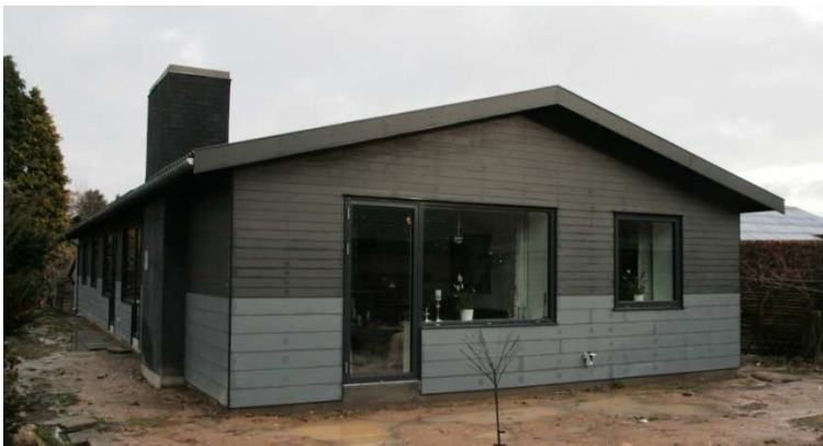
Huset på Udbakken efter energirenoeringen
