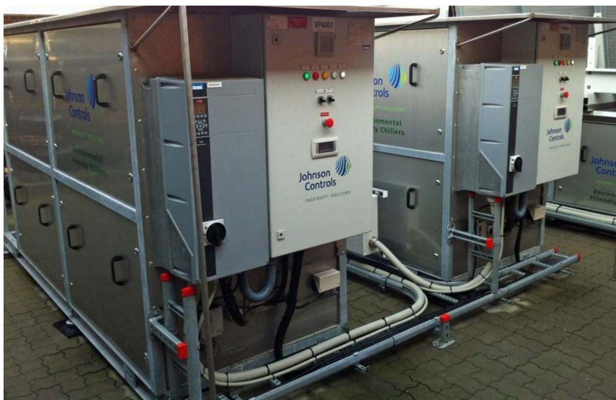
Figur 15: Isobutan-varmepumper installeret på Aarhus Universitetshospital i Skejby.
