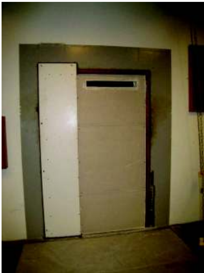
Figur 2 Anlæg set fra den side der er modsat rummet, hvor der er foretaget støjmålinger.
