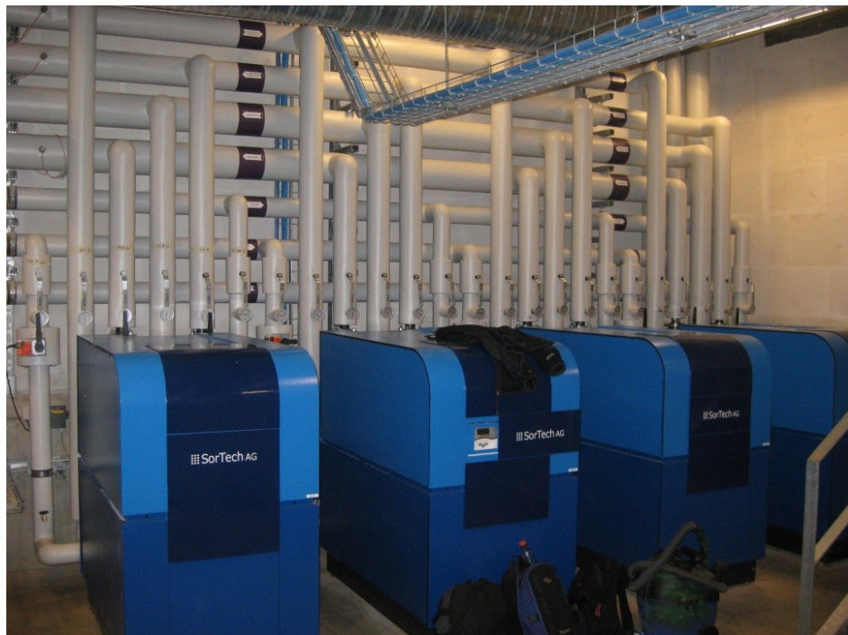
Figur 4.4 De 4 adsorptionsmaskiner i Viborg Rådhus
